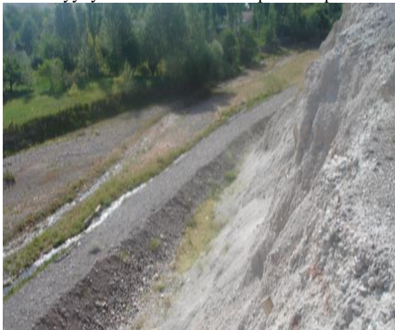
6-сүрөт. Шекафтар шаарчасындагы №3 уулуу тоо таштандысы суунун оң жээгинде жайгашкан. Көлөмү 44,4 мин/м 3 ду ээлейт.
