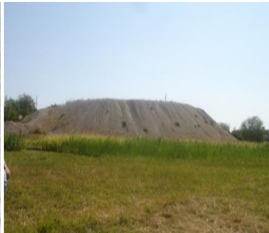
7-сүрөт. Шекафтар шаарчасындагы №4 уулуу тоо таштандысы, айылдын так ортосунда жайгашкан. Көлөмү 60,5 мин/м 3 ду ээлейт.
